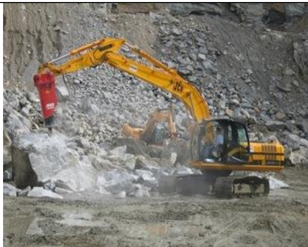
Thi công đập đá tại mỏ
