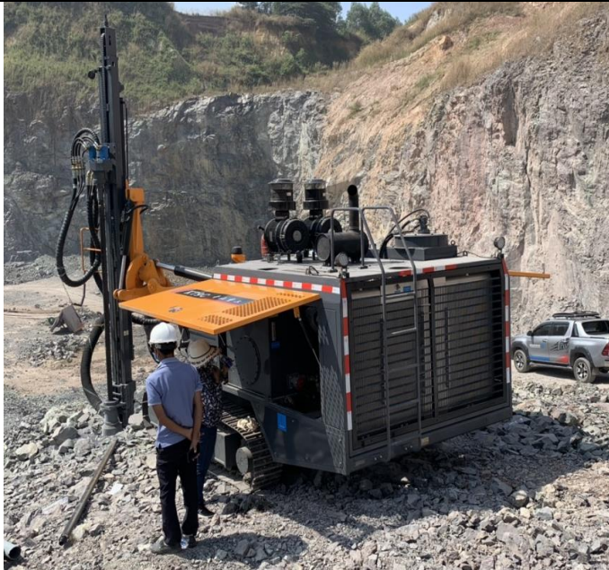
Thi công khoan tại mỏ đá
