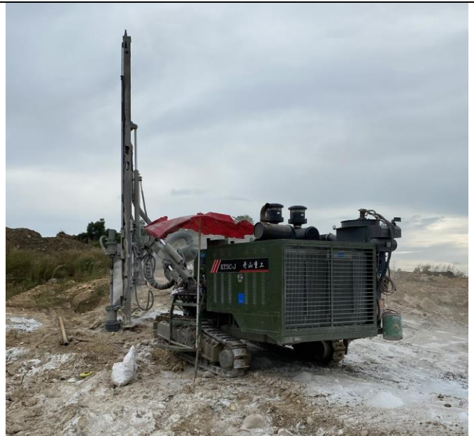
Thi công khoan tại công trình cao tốc Bắc Nam đoạn Km62 – Km63 Xuân Lộc, Đồng Nai
