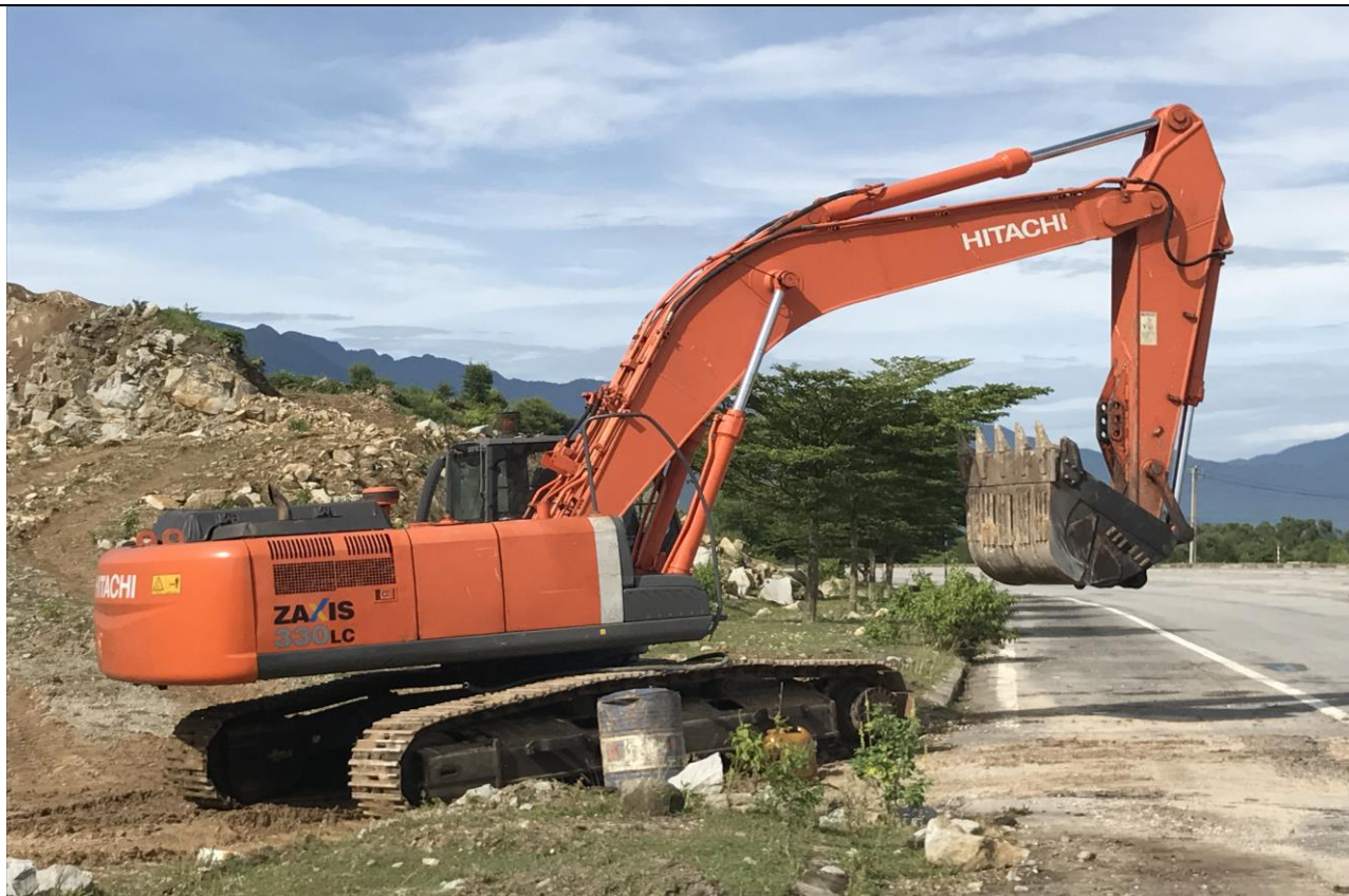
Thi công tại công trình đường tránh Thị xã Phú Mỹ - Bà Rịa Vũng Tàu
