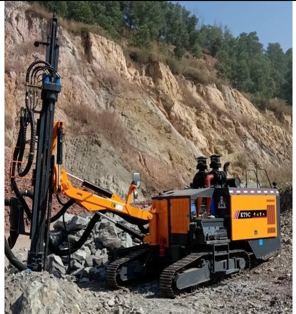
Thi công khoan tại mỏ đá
